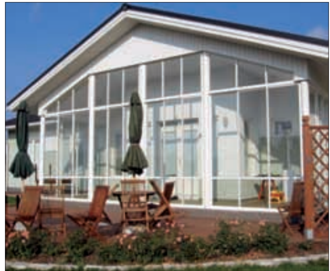
Kiinteän, jaetun 1-lasisen lasituksen asennus
